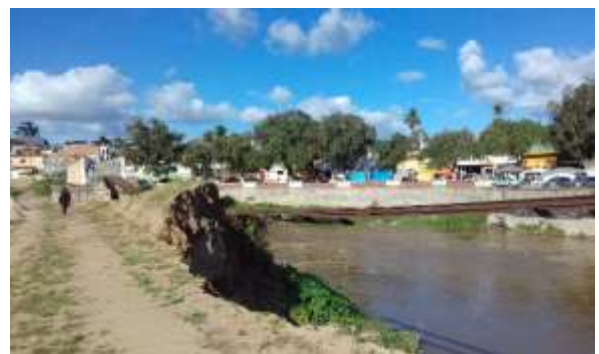
Figura 10 - Trilhos pendurados próximo a ponte Fonte: Júlia Lima e Silva (2018)
