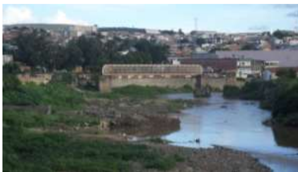
Figura 9 - Vista da ponte de ferro e do Rio Ipojuca Fonte: Júlia Lima e Silva (2018)
