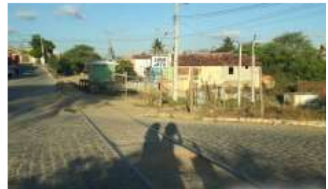
Figura 4 - Residências e trilhos expostos na pavimentação em paralelepípedos. Fonte: Júlia Lima e Silva (2018)
