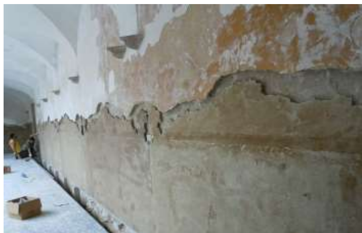
Figura 7: Aplicação do painel antes do assentamento dos azulejos restaurados (Fonte: Grifo, 2011)
