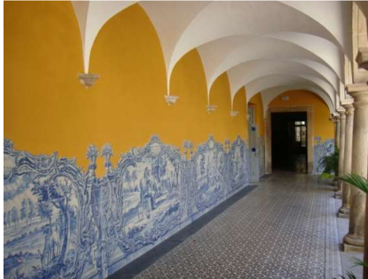
Figura 11: Vista de uma das paredes do claustro, depois da restauração (Fonte: Grifo, 2011)
