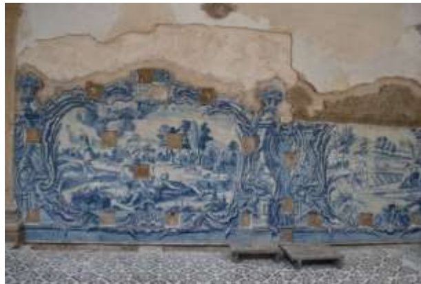
Figura 8: Assentamento dos azulejos na placa, com localização dos parafusos nos painéis (Fonte: Grifo, 2011)
