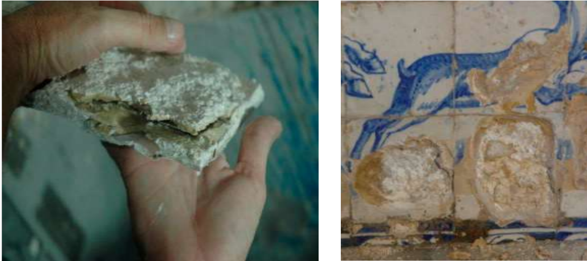
Figuras 2 e 3: Esfoliação no biscoito (à esquerda) e cristais de sais nas lacunas do vitrificado (à direita) (Fonte: Grifo, 2011)
