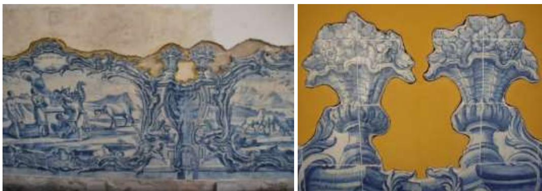
Figuras 9 e 10: Reconstituição do reboco e detalhe de abertura em volta do painel para circulação de ar (Fonte: Grifo, 2011)
