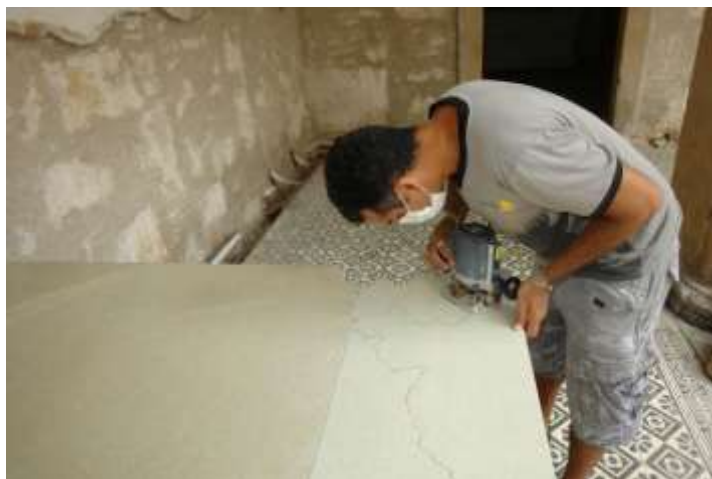
Figura 6: Corte da placa por técnico da Grifo (Fonte: Grifo, 2011)
