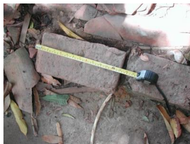
Figura 3 - Tamanho do tijolo maciço e de fragmentos de telha cerâmica Fonte: Elaborado pela autora
