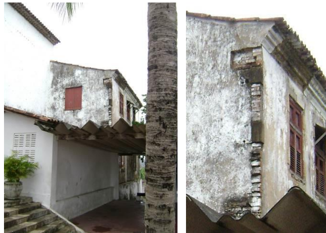
Figura 5 – vista da fachada lateral e detalhe das ombreiras das janelas Fonte: Elaborado pela autora
