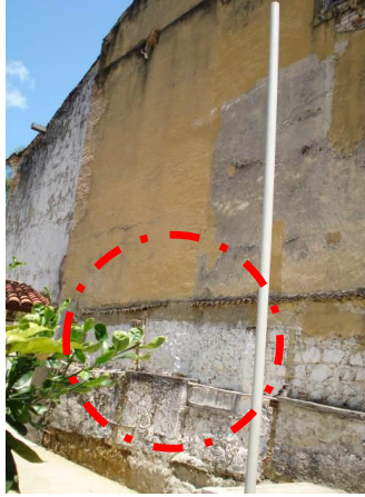
Figura 4 – Base da capela em pedras. Fonte: Elaborado pela autora
