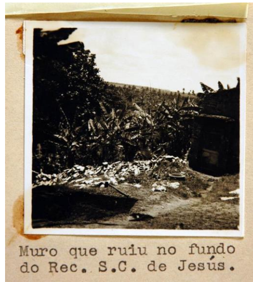
Figura 1 – Muro que ruiu no fundo do Recolhimento do Sagrado Coração de Jesus. Fonte: 5ª. IPHAN
