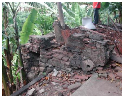
Figura 2 - Ver arranjos de tijolos maciços do antigo refeitório. Fonte: Elaborado pela autora
