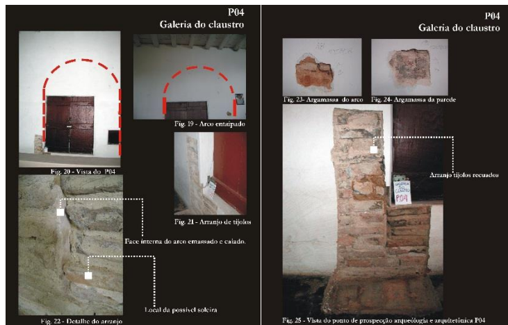
Figura 21 – Localização dos pontos das prospecções arqueológica e arquitetônica na Galeria do Claustro. Pontos de coleta de argamassa. Fonte: Elaborado pela autora
