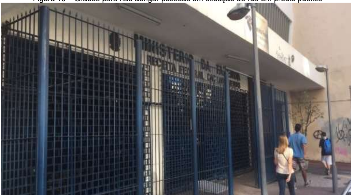
Figura 13 – Grades para não abrigar pessoas em situação de rua em prédio público
