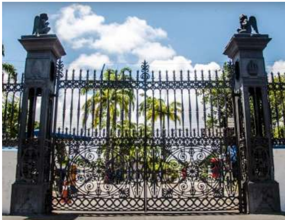
Figura 28 – Portão da entrada principal em ferro, Cemitério de Santo Amaro, Recife-PE.
