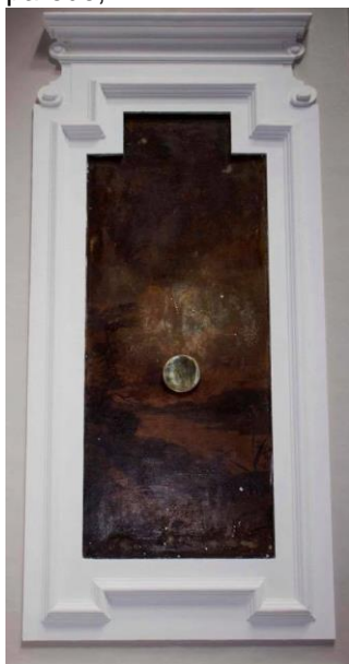
Figura 72 - Detalhe da parede, IEP 24.
