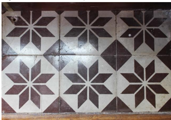
Figura 70 - Detalhe do piso, IEP 24.
