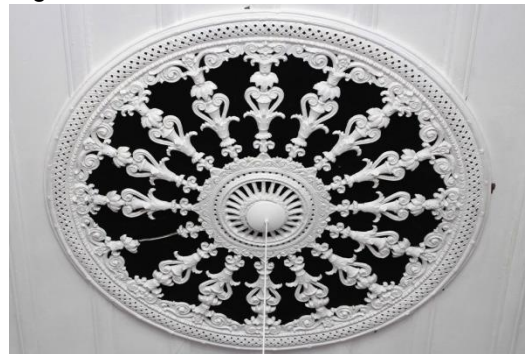
Figura 69 - Detalhe do teto, IEP 24.
