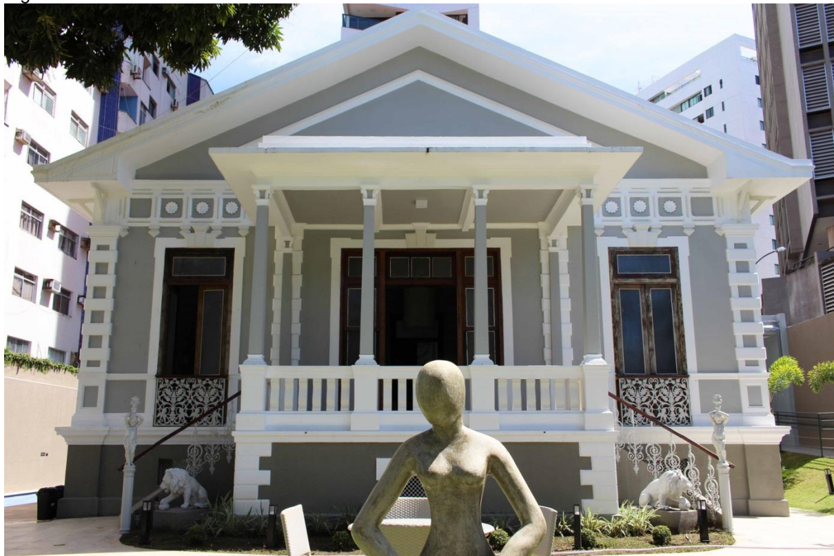
Figura 58 - Fachada frontal IEP 24.
