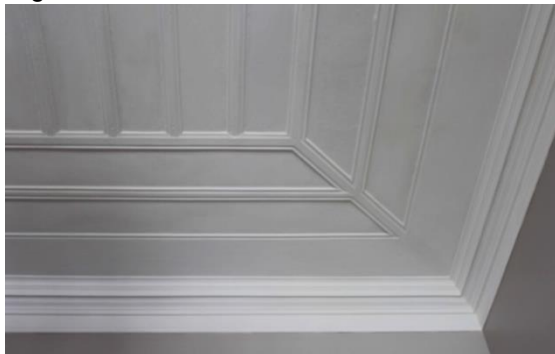
Figura 68 - Detalhe do teto, IEP 24.
