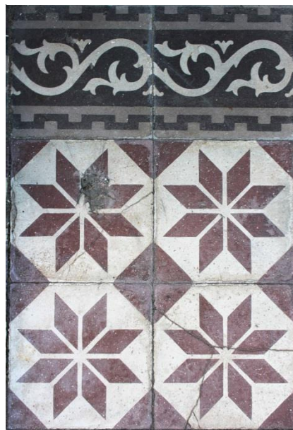
Figura 73 - Detalhe do piso, IEP 24.
