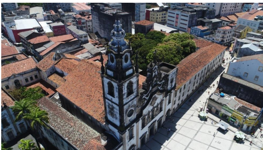
Figura 54 - Fotografia aérea da Basílica Nossa Senhora do Carmo registrada por drone.
