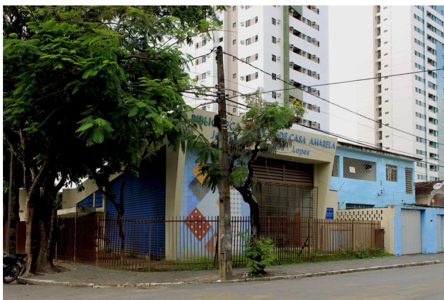
Figura 57 - Fotografia térrea IEP 79 visualizando as edificações vizinhas.
