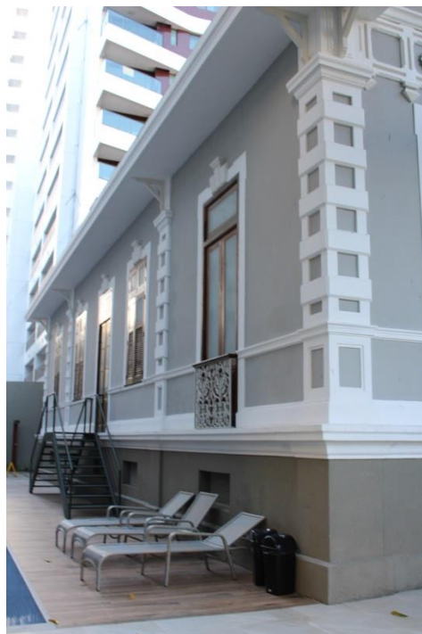
Figura 60 - Fachada lateral esquerda IEP 24.
