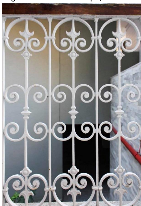
Figura 63 – Guarda corpo, IEP 24.
