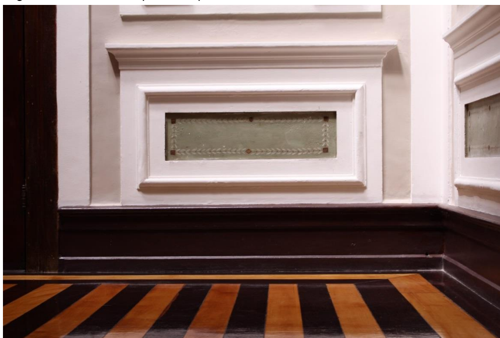
Figura 67 – Detalhe da parede e piso, IEP 24.
