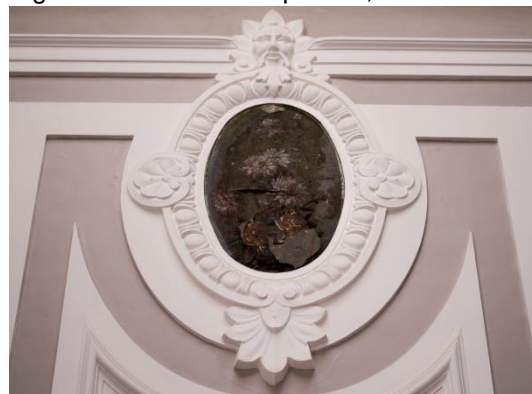
Figura 71 - Detalhe da parede, IEP 24.
