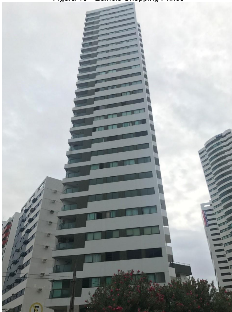
Figura 19 - Edifício Shopping Prince
