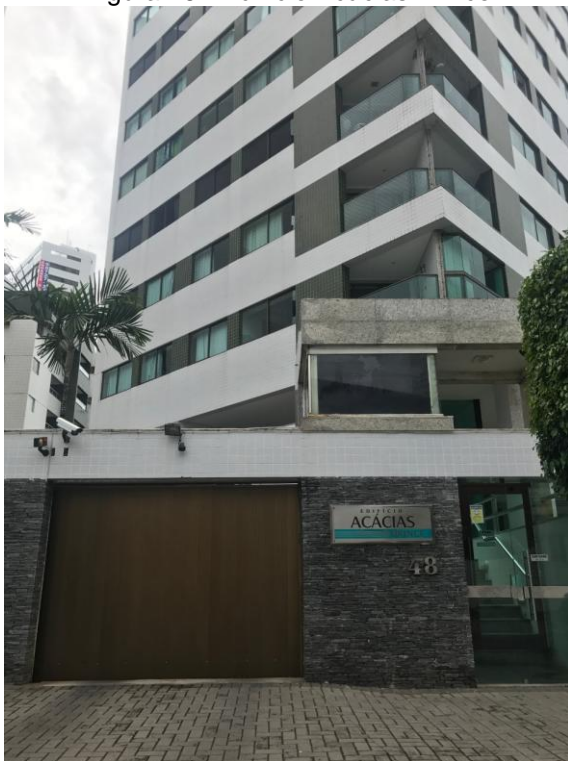
Figura 16 - Edifício Acácias Prince
