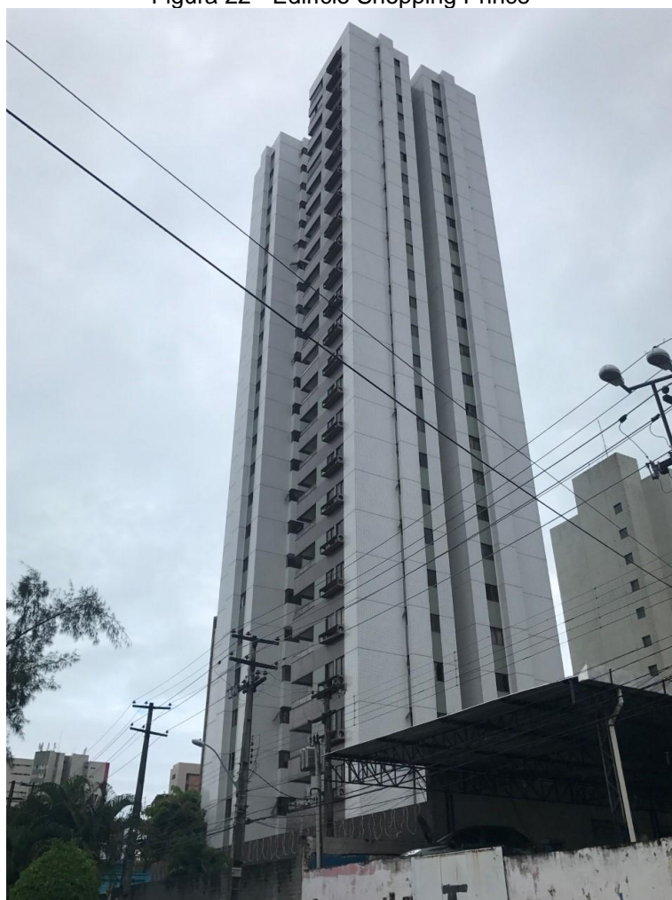
Figura 22 - Edifício Shopping Prince
