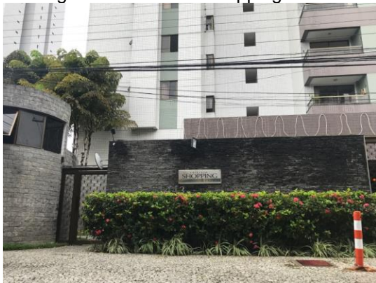
Figura 20 - Edifício Shopping Prince
