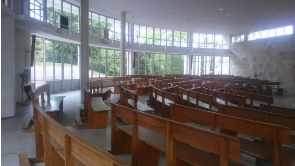
Figura 73 – Fechamento da nave em esquadrias, quase que por completo.
