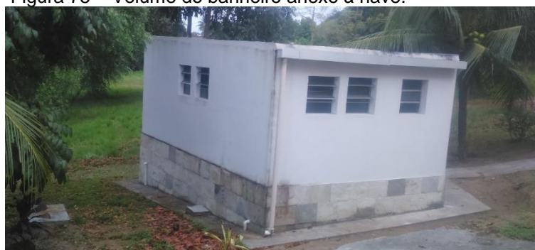
Figura 75 – Volume do banheiro anexo à nave.
