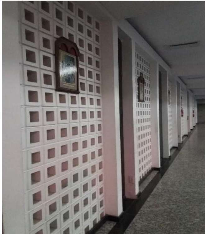
Figura 45 - Paredes laterais em cobogó.
