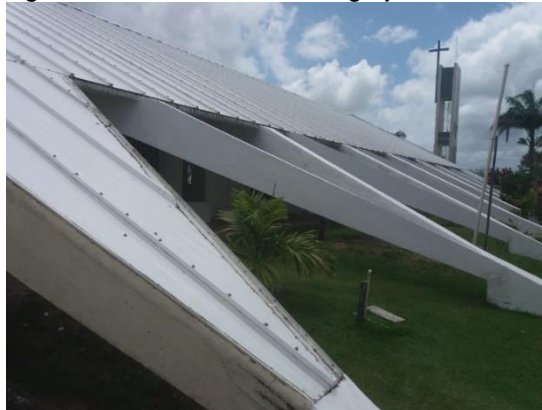
Figura 62 - Nova cobertura da igreja.
