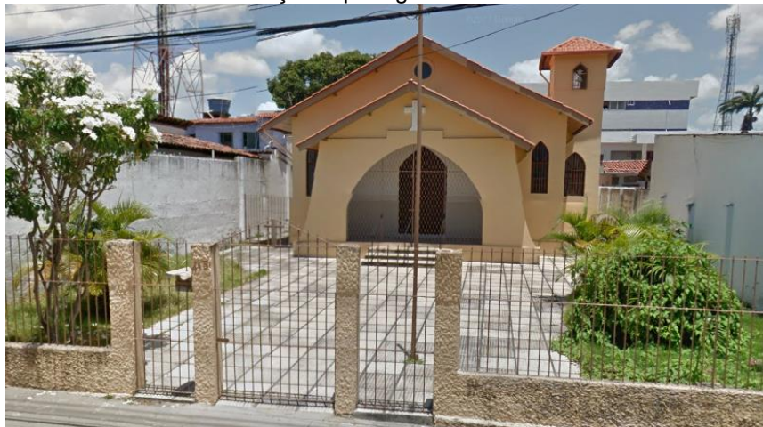
Figura 29 - Capela de São Severino Mártir - Subordinada à Paróquia de Nossa Senhora da Conceição - Iputinga.
