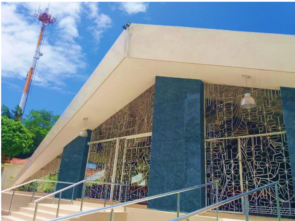
Figura 51 - Fachada da Matriz após reforma.
