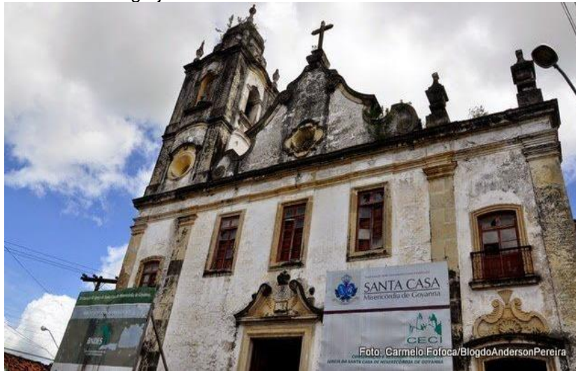
Figura 6 - Fachada externa da Igreja da misericórdia.
