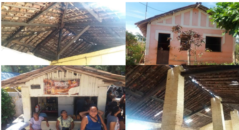
Figura 54 - Coberta de algumas edificações mostrando a estrutura.
