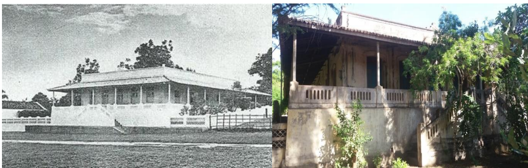
Figura 24 – Imagem mostrando a Casa-Grande antes (s.d.) e depois (2017).
