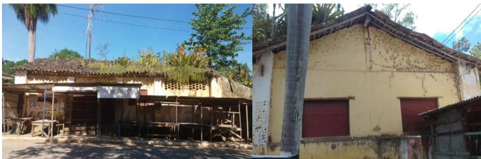
Figura 40 - Antiga Casa de Purgar do Engenho Ramos.
