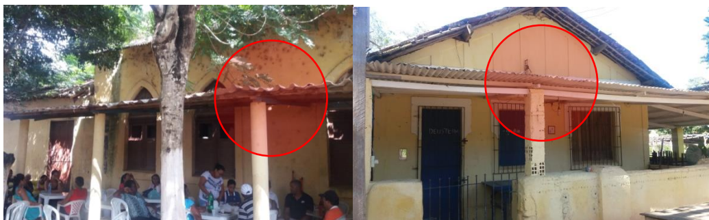
Figura 57 - Cobertas de fibrocimento em frente aos imóveis da escola e residência dos moradores do Ramos.
