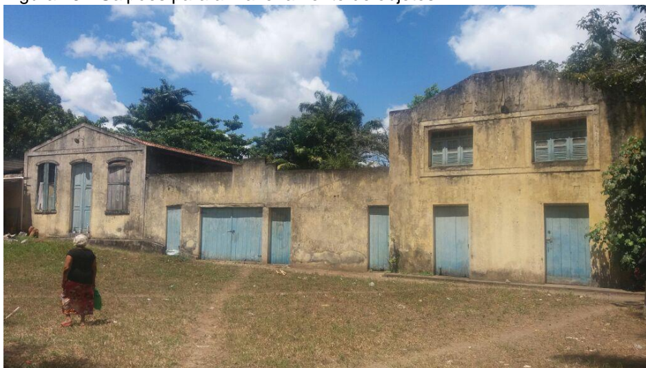
Figura 23 - Galpões para armazenamento de objetos.
