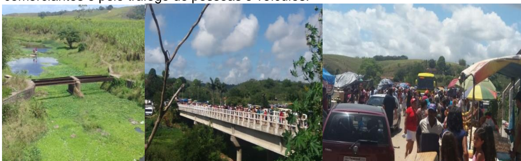
Figura 33 - Vestígios da antiga ponte (esquerda) e ponte atualmente sendo ocupada por comerciantes e pelo tráfego de pessoas e veículos.
