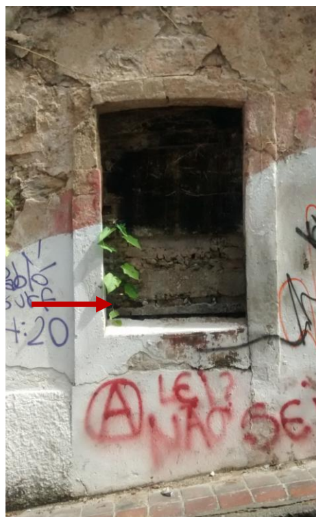
FIGURA 42: Fechamento de vão
