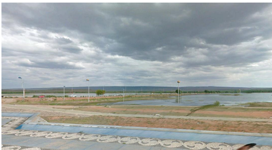
FIGURA 64 – Vista para a ponte de acesso da BR-316
