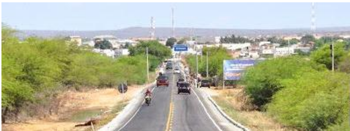
FIGURA 63 – Acesso a cidade pela BR-316
