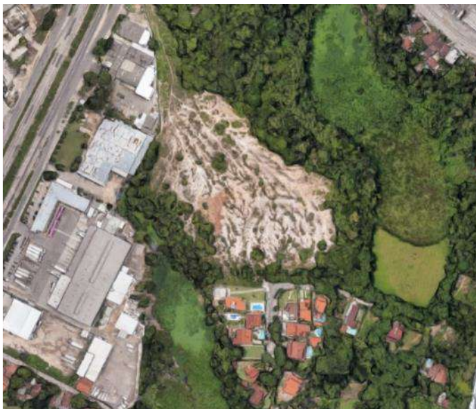
Figura 28 – Ampliação da área 1: Área em processo erosivo.
