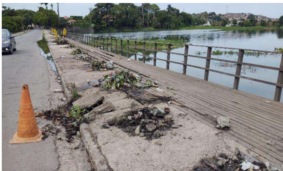
Figura 17 - Trechos da Rua Cel. João Batista do Rêgo Barros com lixos retirados da água do açude.
