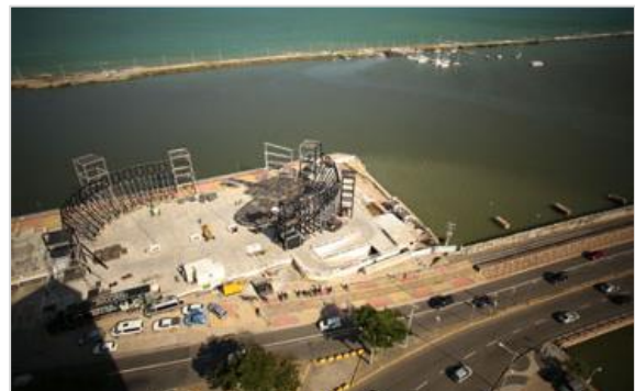
Figura 27: Situação atual do teto do estacionamento, com estrutura para show sendo montada.
