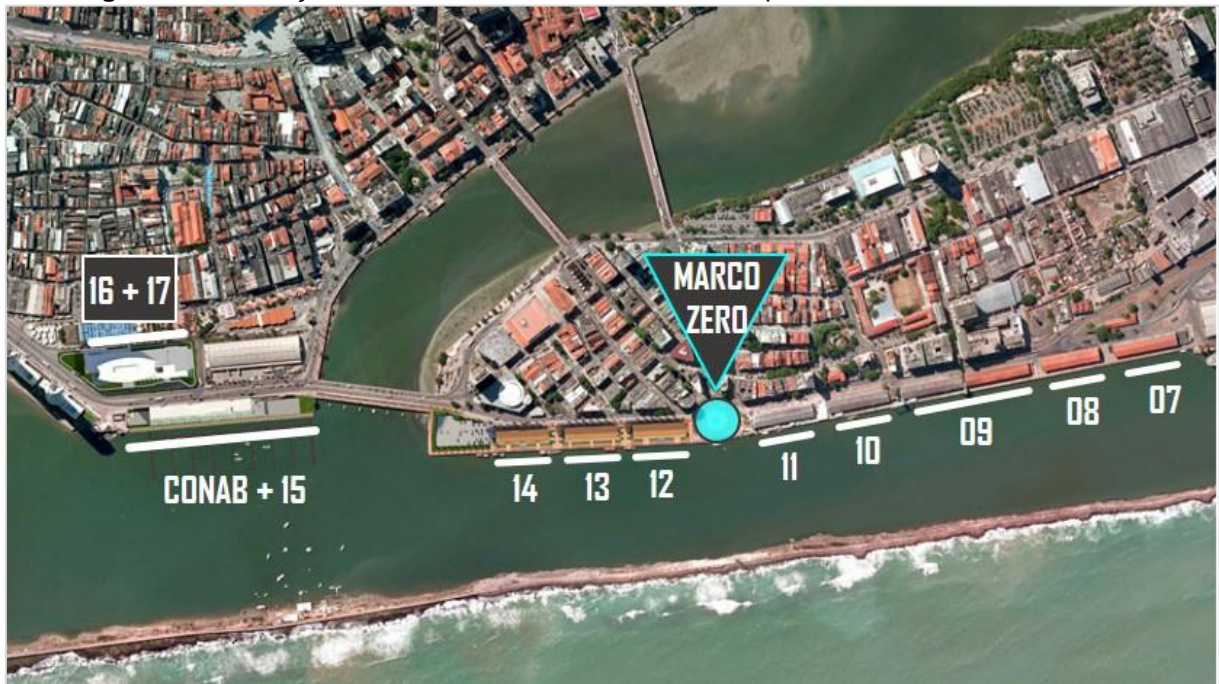
Figura 2: Localização das estruturas dos armazéns não-operacionais do Porto do Recife.
