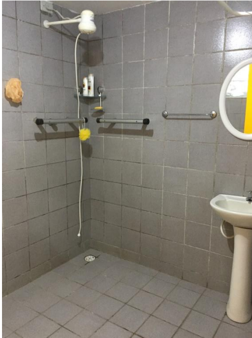
Figura 36: Banheiro do quarto idoso, ILPi 3.
