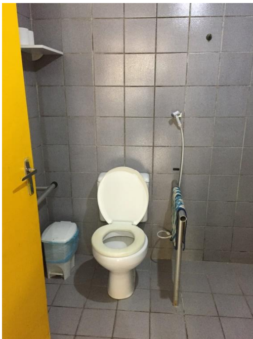
Figura 35: Banheiro do quarto idoso, ILPi 3.
