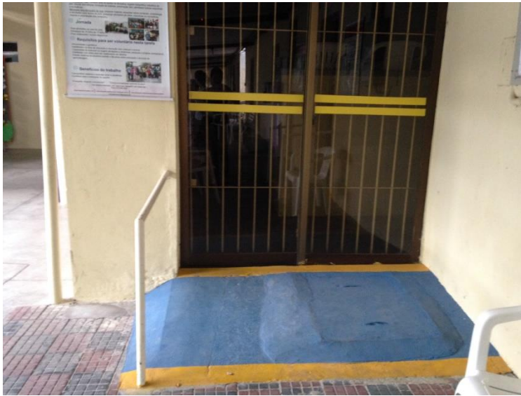
Figura 20: Rampa com corrimão, ILPI 1.
