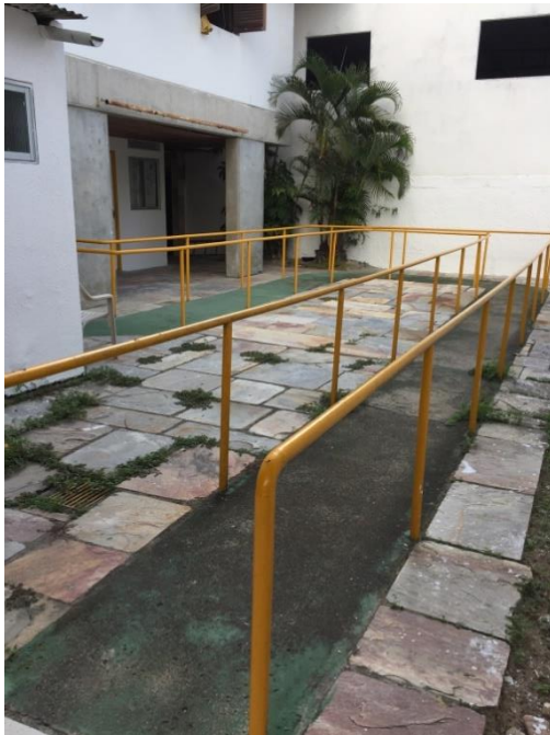
Figura 38: Área para caminhar com corrimão, ILPi 3.
