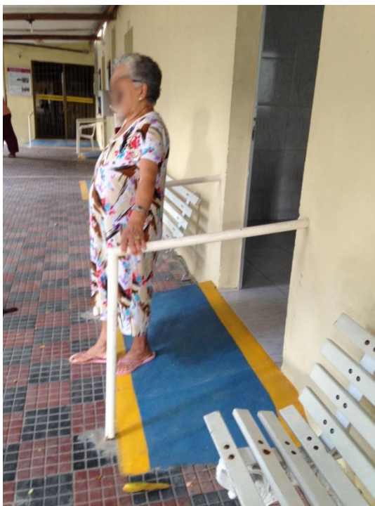
Figura 19: Rampa com corrimão, ILPI 1
