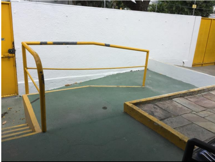
Figura 41: Rampa de acesso principal da casa com corrimão, ILPi 3.
