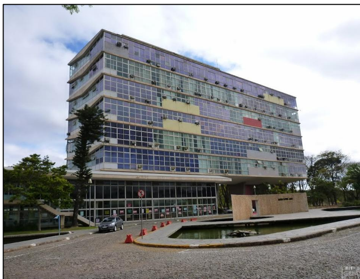
Figura 9. O edifício da Reitoria da UFMG
