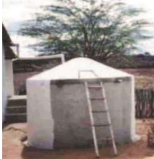
Figura 17 – Cisterna de concreto e arame.
