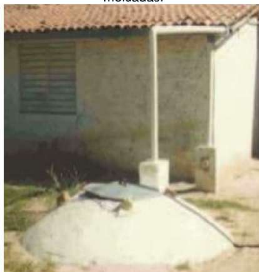
Figura 19 – Cisterna de placas de cimento pré-moldadas.
