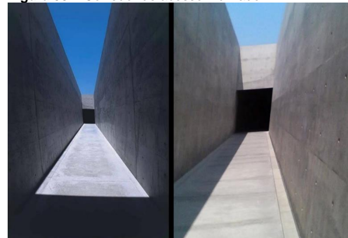
Figura 55 – Corredor de acesso inclinado.
