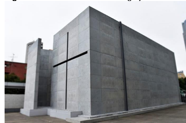
Figura 39 – Fachada externa da Igreja da Luz.
