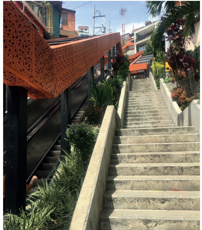
Figura 10 – Escadas rolantes e fixas, Comuna 13.
