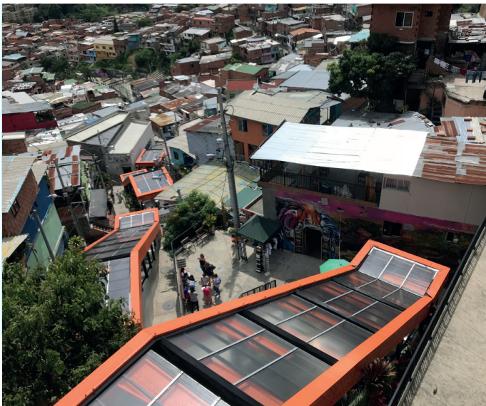
Figura 11 – Escadas rolantes, Comuna 13: visão superior do conjunto.
