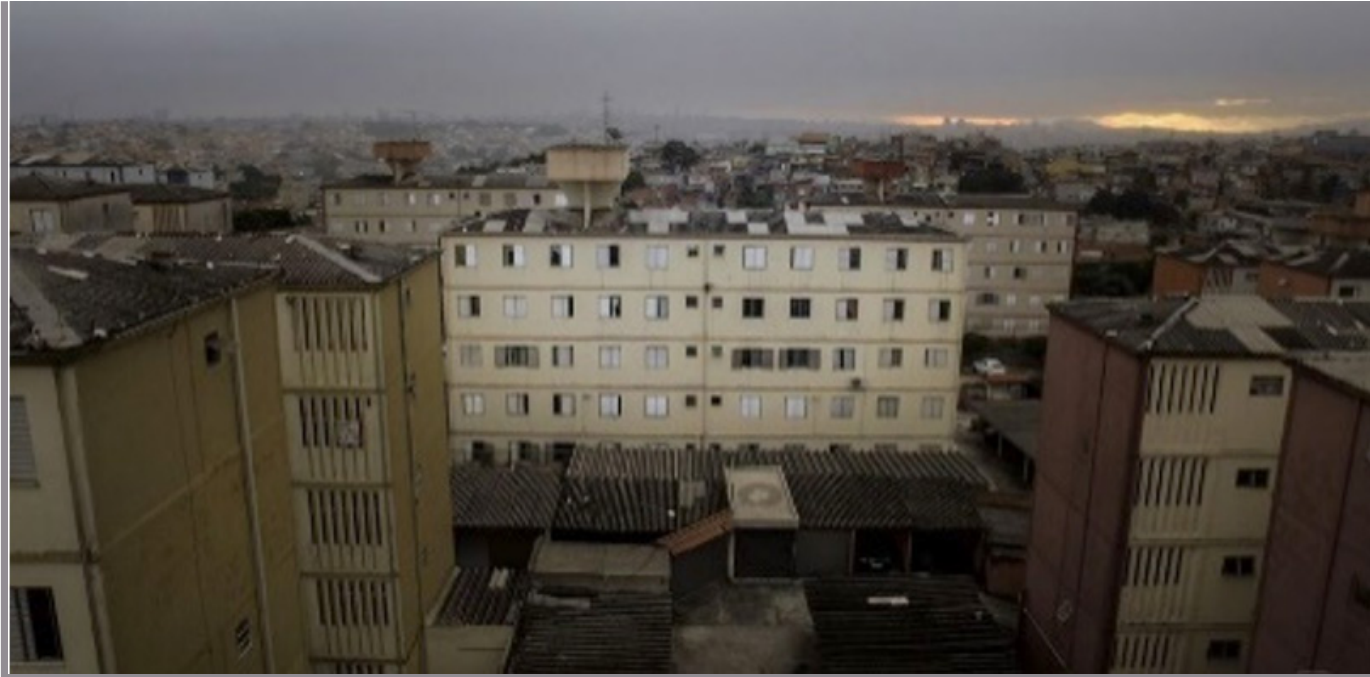
Figura 20 ■ Cohab 1 1970, localizado em São Paulo, Zona Leste da cidade Fonte ■ Alves, 2020.
