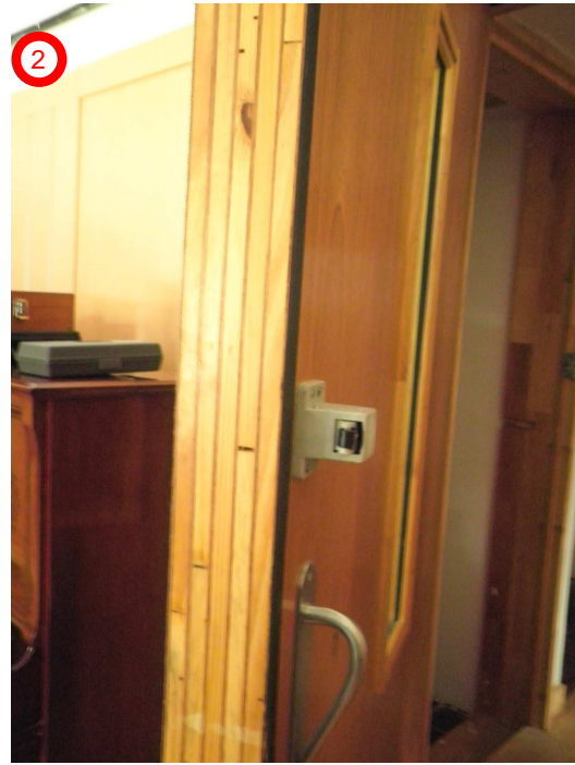
FIGURA 72: Detalhe do tipo de fechadura da porta.
