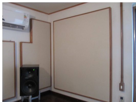
FIGURA 51: Sala de mixagem C.
