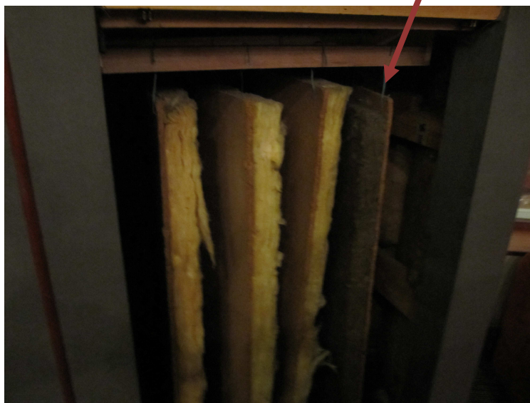
FIGURA 25: Detalhe da armadilha de grave, composta de placas de madeira com lã de rocha.
