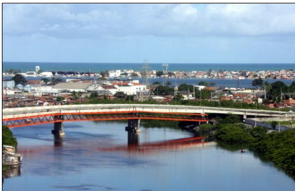
FIGURA 39: Ponte Joaquim Cardoso
