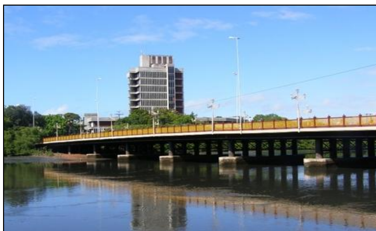
FIGURA 36: Ponte 06 de Março - 01
