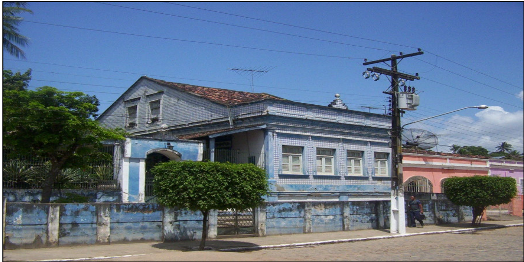
FIGURA 35: Imóvel com recuo lateral, revestido com azulejo francês. Rua Luiz Maranhão.
