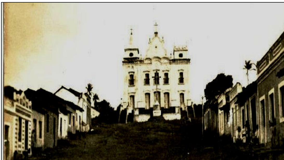
FIGURA 49: Capela de Nossa Senhora do Livramento dos Homens Pardos – Paudalho
