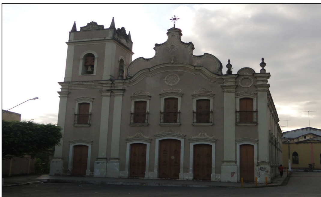
FIGURA 32: Barroco – Fachada da Igreja Matriz – Paudalho. FONTE: Autor da pesquisa, 2010.
