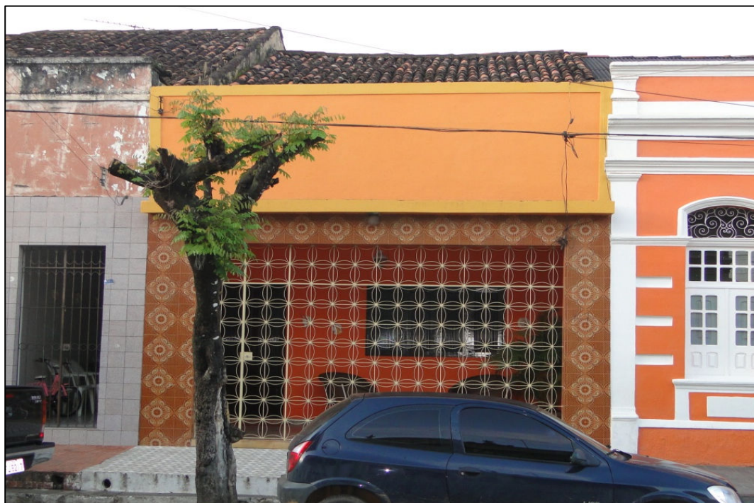
FIGURA 40: Imóvel Antigo Descaracterizado – Rua João Alfredo - Paudalho FONTE: Autor da pesquisa, 2010.
