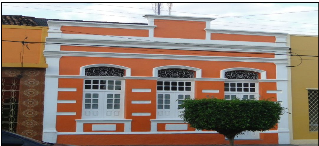
FIGURA 36: Imóvel do Início Séc. XX - Rua João Alfredo - Paudalho
