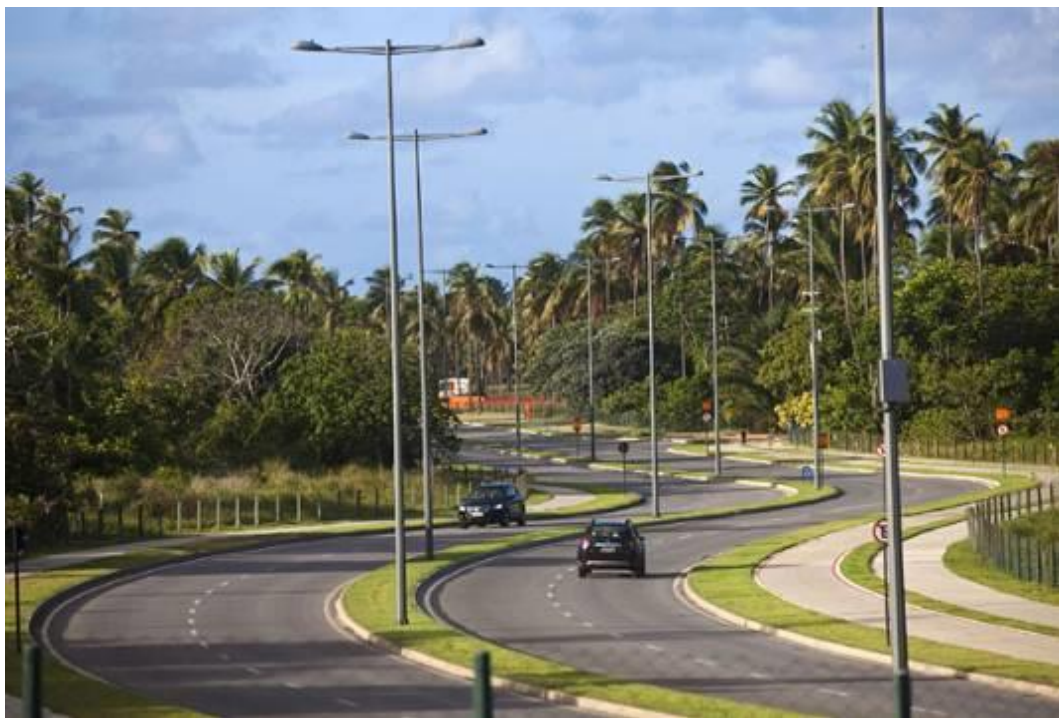
Figura 15: Sistema viário, ciclofaixa e acessibilidade da Reserva do Paiva. Fonte: Rota dos Coqueiros/Divulgação (CARRÉRA, 2012).
