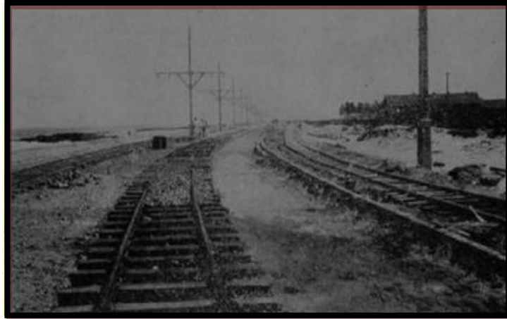
FIGURA 123: Construção da linha férrea na beira mar do Pina
