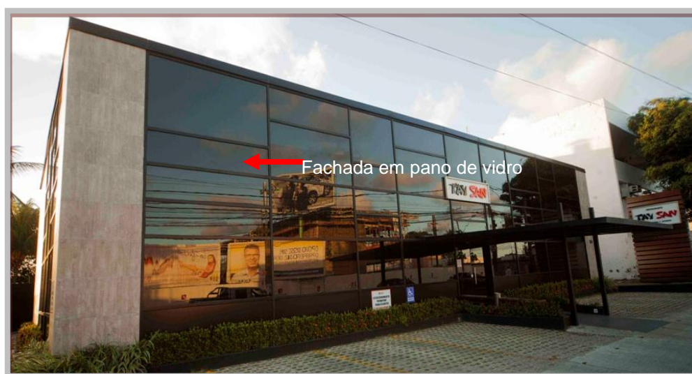
FIGURA 63: Fachada do Restaurante Koy Sushi
