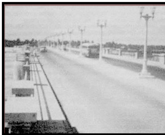
FIGURA 122: Ponte Agamenon Magalhães, inaugurada em 1953.
