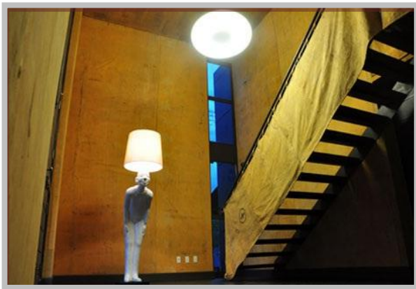
FIGURA 111: Escada de acesso ao segundo andar. Em madeira com ambiente revestido em lona
