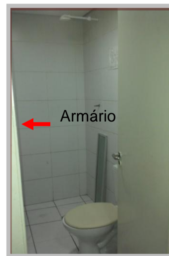
FIGURA 41: Banheiro e Vestiário dos Funcionários.
