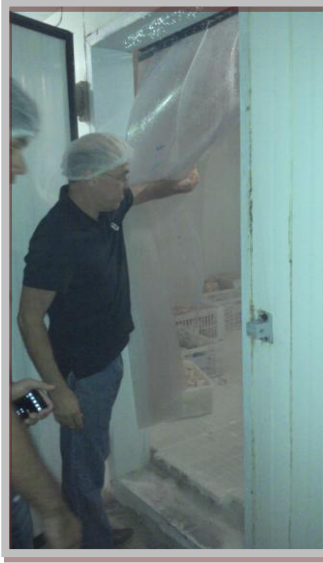
FIGURA 88: Acesso das câmaras por portas frigoríficas.
