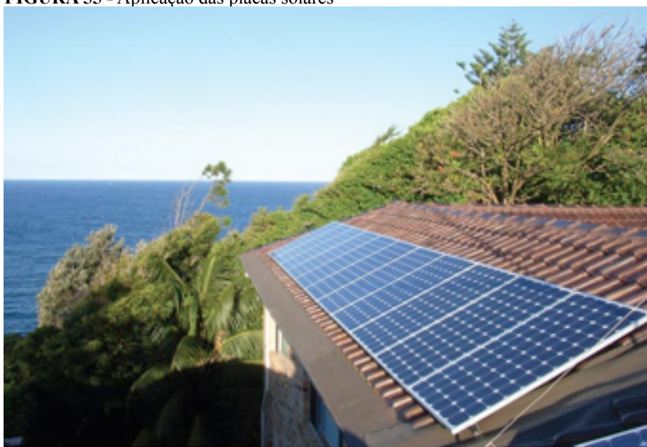
FIGURA 55 - Aplicação das placas solares
