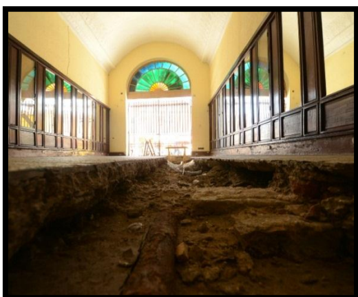
FIGURA 22 – Reforma da parte hidráulica do Teatro do Parque- PE
