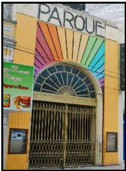
FIGURA 16 – Fachada do Teatro do Parque- PE
