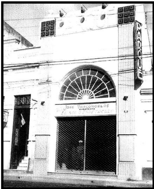
FIGURA 15 – Fachada do Teatro do Parque- PE
