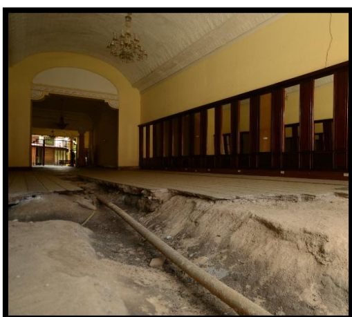
FIGURA 23 – Reforma da parte hidráulica do Teatro do Parque- PE
