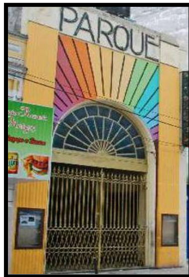
FIGURA 14 - Fachada do Teatro do Parque-PE
