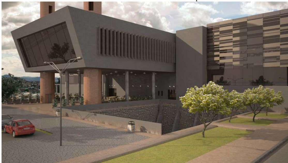
FIGURA 105: Mezanino e torres com elevador panorâmico.
