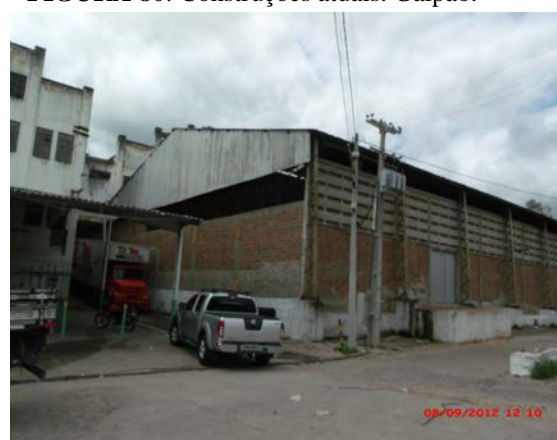
FIGURA 80: Construções atuais. Galpão.
