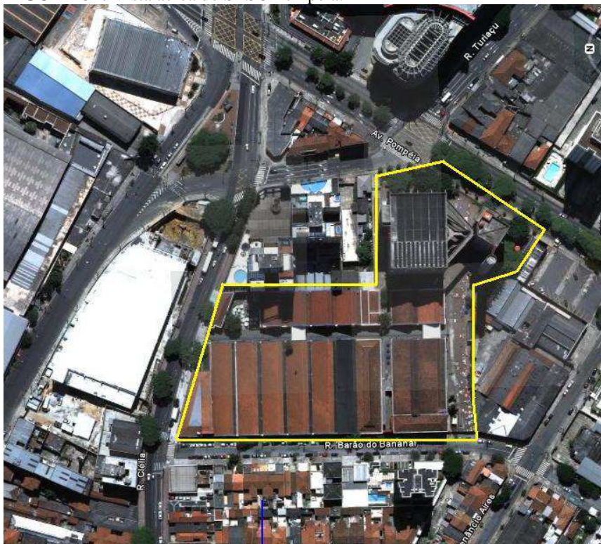
FIGURA 31: Vista aérea do SESC Pompéia.
