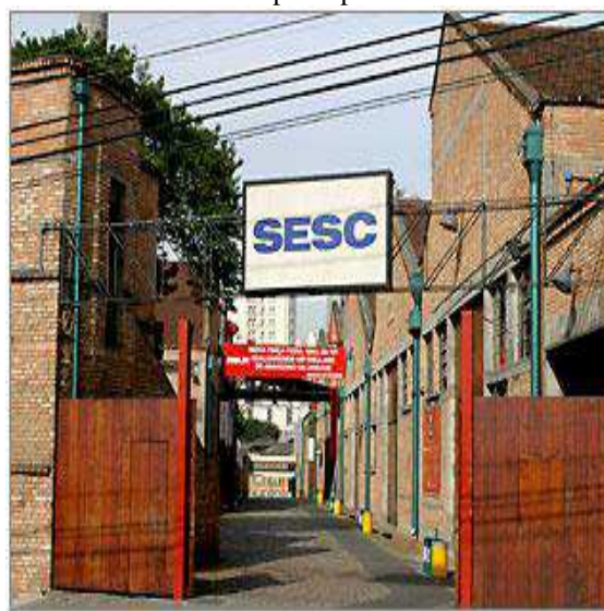
FIGURA 34: Acesso principal ao SESC.
