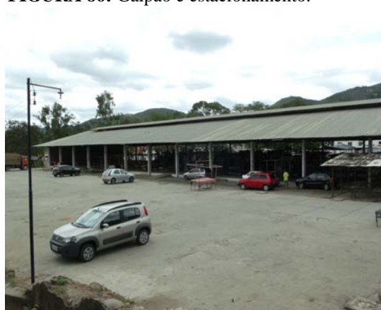
FIGURA 86: Galpão e estacionamento.
