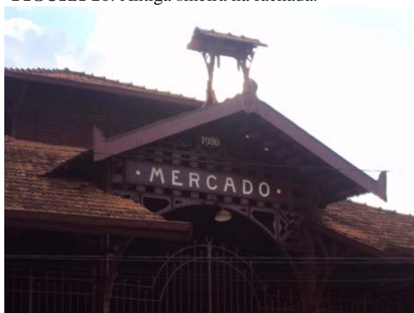
FIGURA 16: Antiga sineira na fachada.
