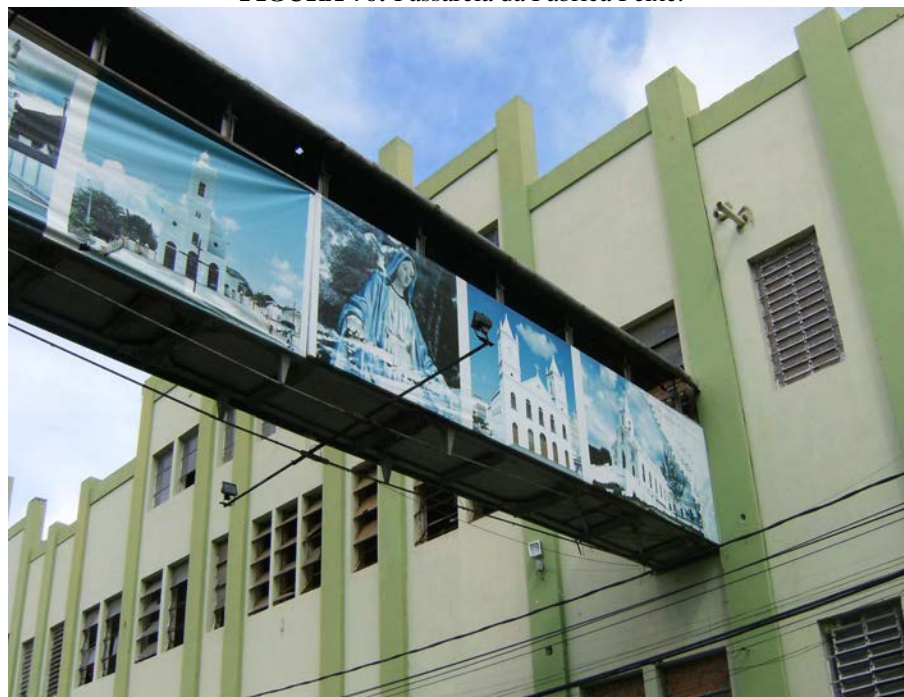
FIGURA 76: Passarela da Fábrica Peixe.
