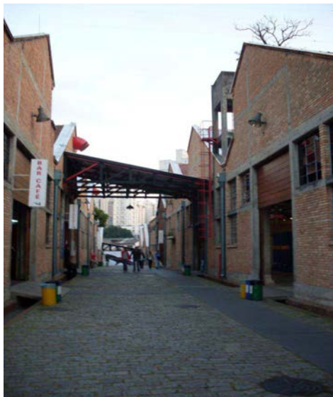
FIGURA 33: Acesso ao novo bloco do SESC.
