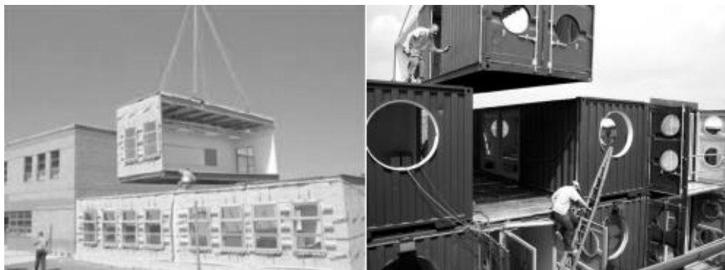
Figura 7 - Exemplo de construções modulares parcialmente abertas
