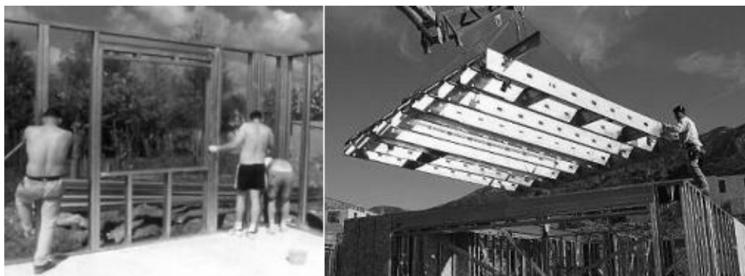
Figura 9-- Exemplo de sistemas construtivo de elementos modulares
