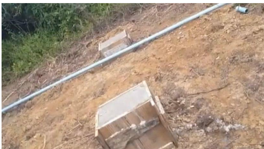
Figura 19 - Fundação no terreno casa guabiraba
