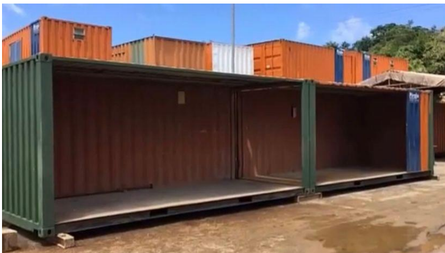
Figura 18 - Containers em fase de adaptação casa Guabiraba
