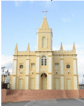
Figura 31: Fachada da matriz de N.S. da Conceição
