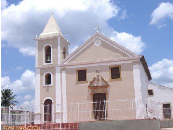
Figura 41: Fachada matriz de Santo Antônio
