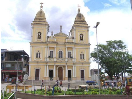
Figura 50: Fachada da Catedral de N.S. da Conceição
