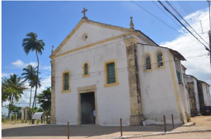
Figura 19: Fachada da matriz de São Lourenço
