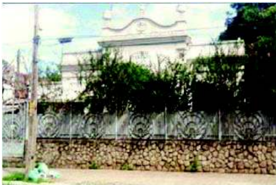
Figura 15: IEP 92 – Praça de Casa Forte, 354, Casa Forte.
