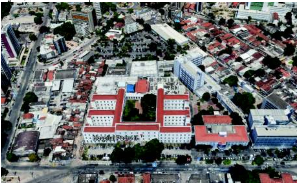
Figura 6: Vista aérea do Hospital Pedro II.
