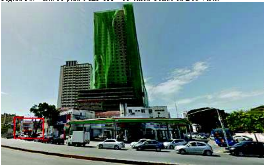
Figura 38: Vista 01 para o IEP 155 – Avenida Conde da Boa Vista.
