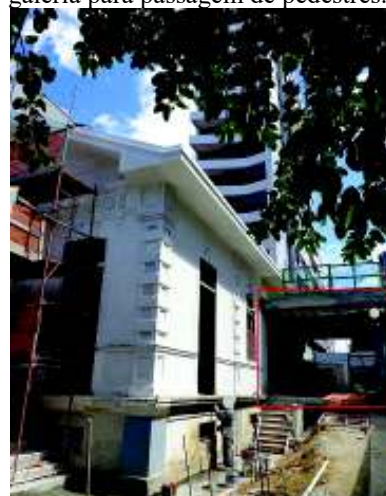
Figura 49: Anexo da fachada esquerda que será mantido em forma galeria para passagem de pedestres.
