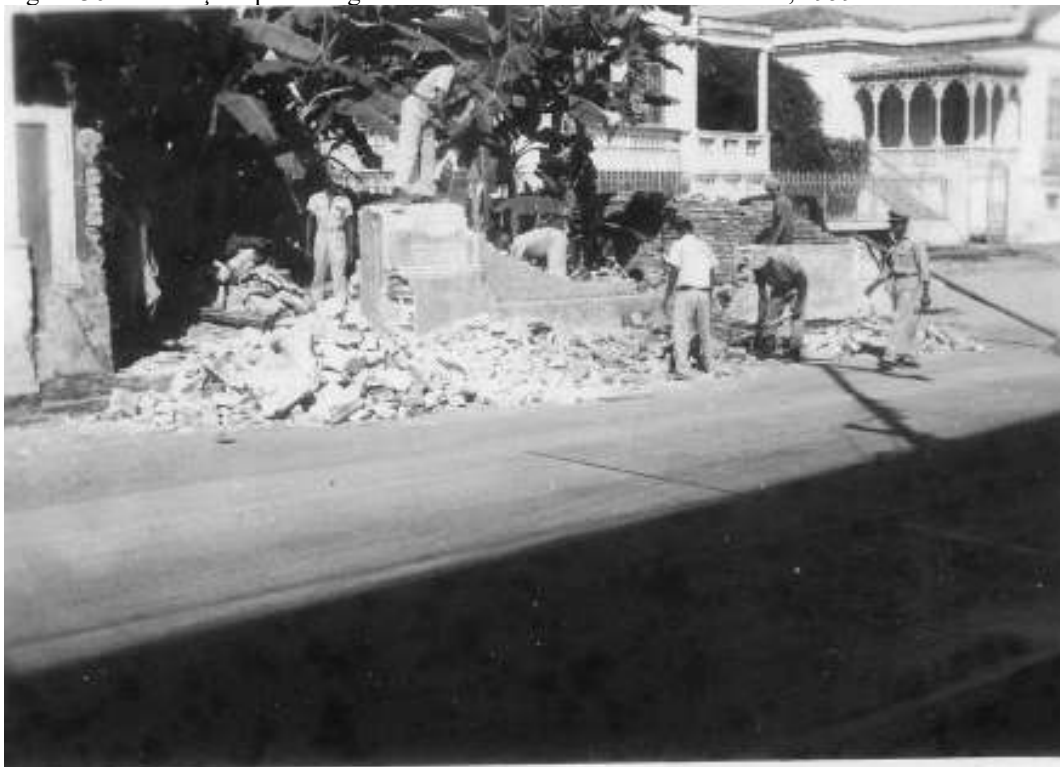
Figura 36: Demolições para alargamento da Avenida Conde da Boa Vista, 1959.
