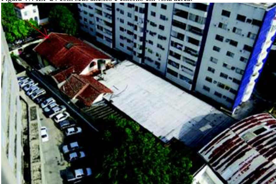
Figura 47: IEP 24 com seus anexos e entorno em vista aérea.
