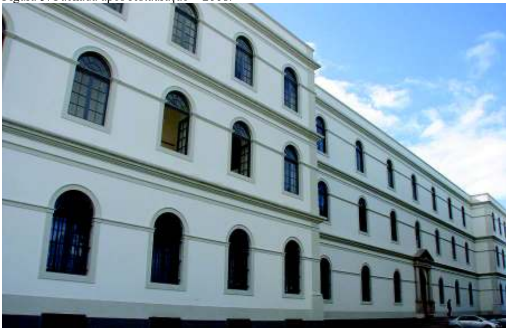
Figura 5: Fachada após restauração – 2008.
