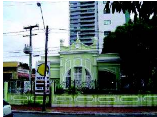
Figura 16: IEP 92 – Praça de Casa Forte, 354, Casa Forte.
