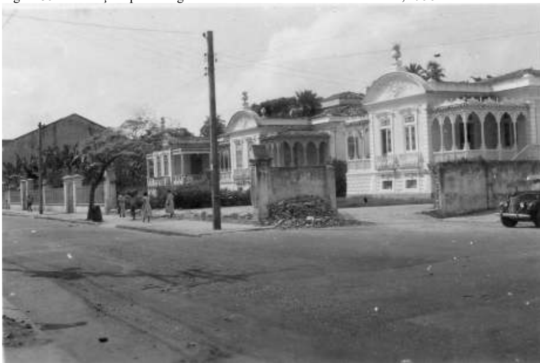
Figura 35: Demolições para alargamento da Avenida Conde da Boa Vista, 1958.
