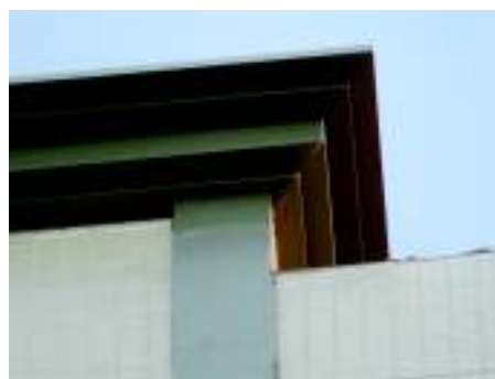
Figura 41 - Detalhe do coroamento.
