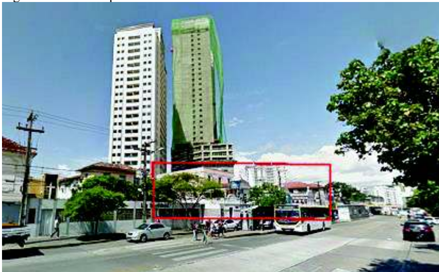
Figura 39: Vista 02 para o IEP 155 – Avenida Conde da Boa Vista.
