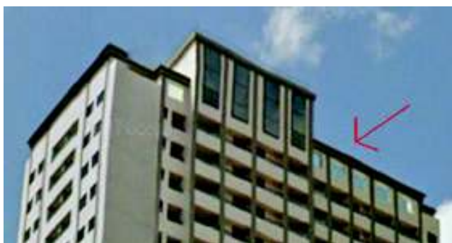
Figura 40: Coroamento do novo edifício.
