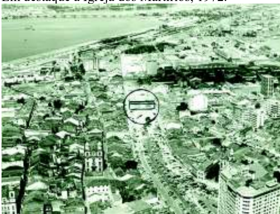
Figura 8: Obra de abertura da Avenida Dantas Barreto. Em destaque a Igreja dos Martírios, 1972.
